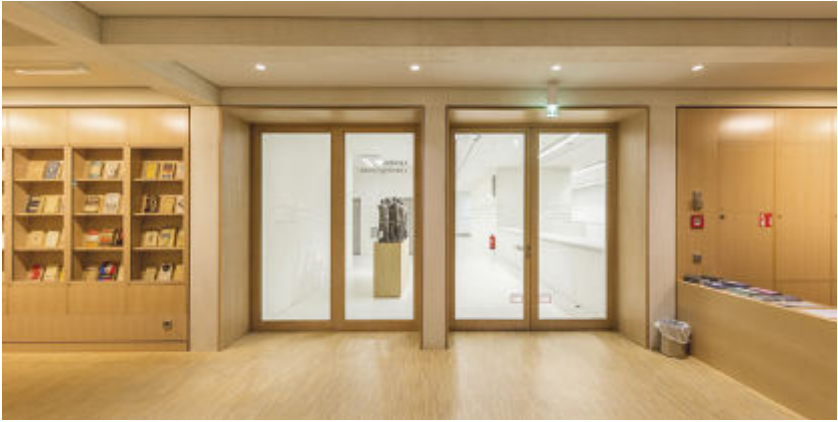
T30-Türen mit allgemeiner bauaufsichtlicher Zulassung, vom Innungsschreiner gefertigt
