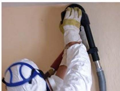
Schimmelpilzsanierung mit Putzfräse
