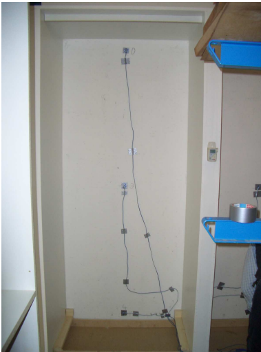
Abb.: Messstellen beim hinterlüfteten (links) und geschlossenen (rechts) Einbauschränk, Quelle: V. Hägele
